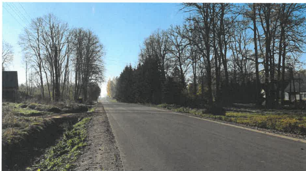
Droga nr 1262B po przebudowie
