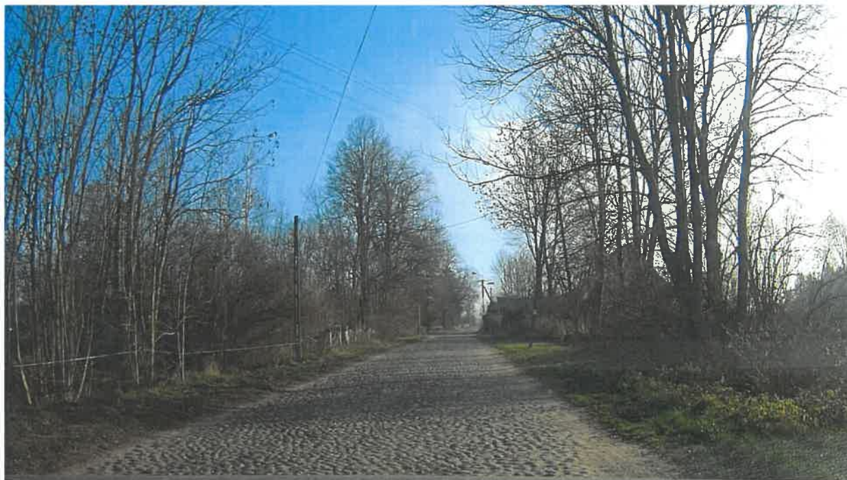
Droga nr 1259B przed przebudową
