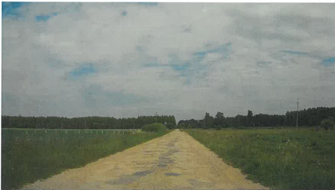
Droga 1262B przed przebudową
