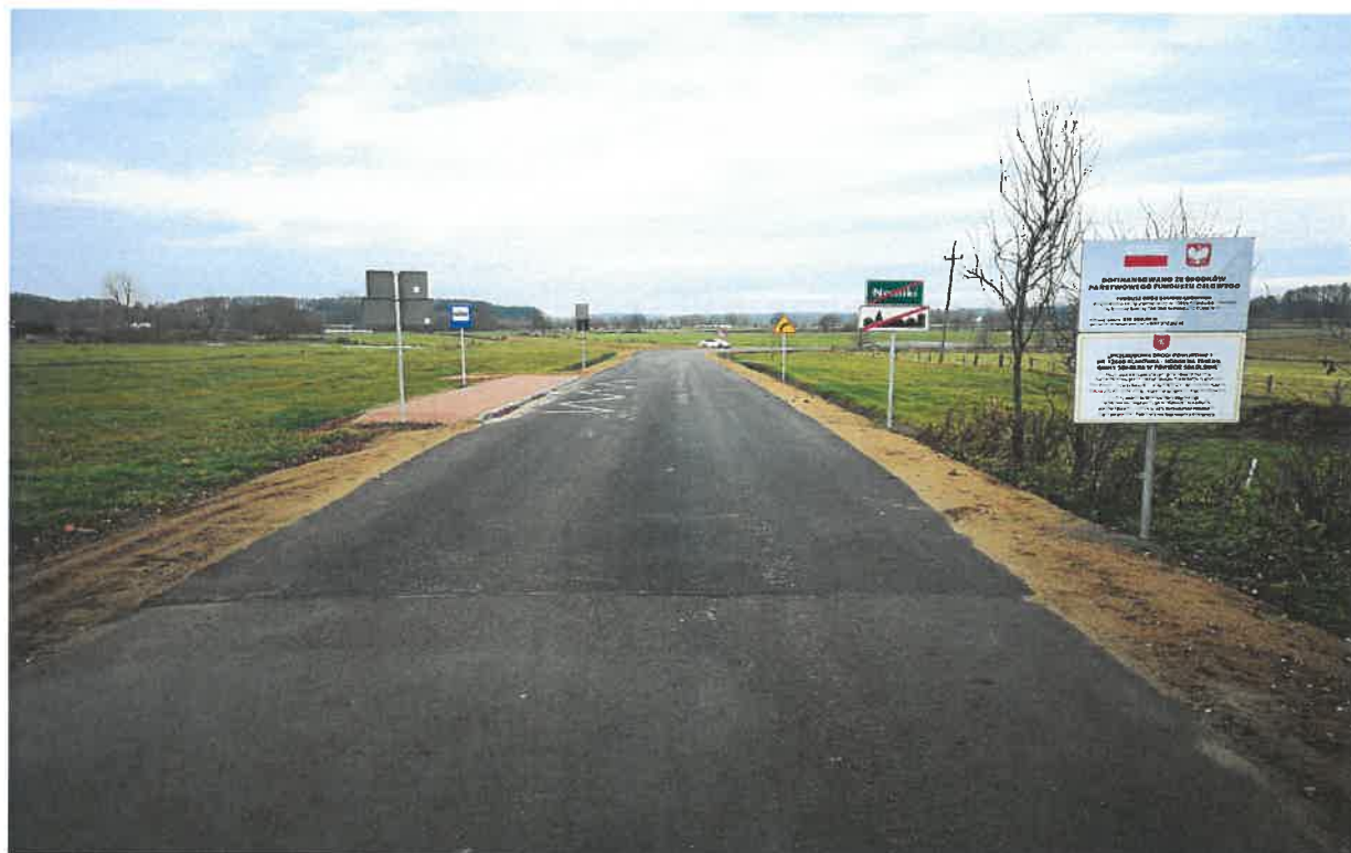
Droga nr 1266B po przebudowie
