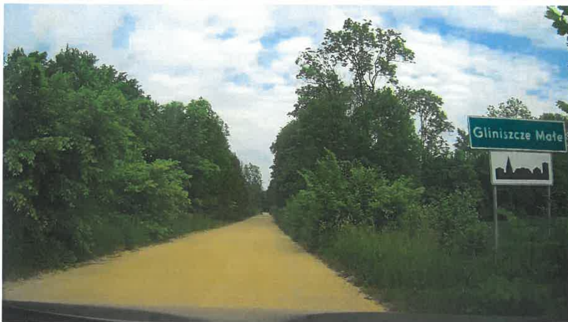
Droga nr 1262B przed przebudową
