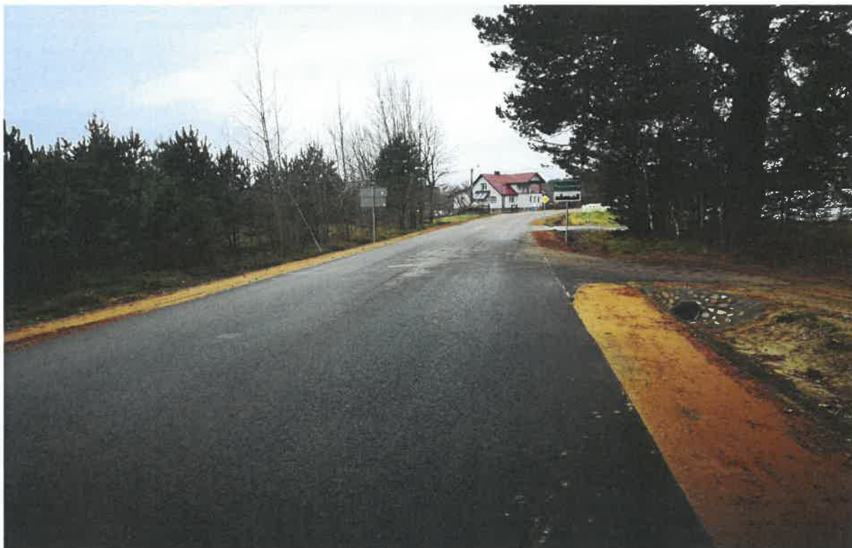
Droga nr 1266B po przebudowie
