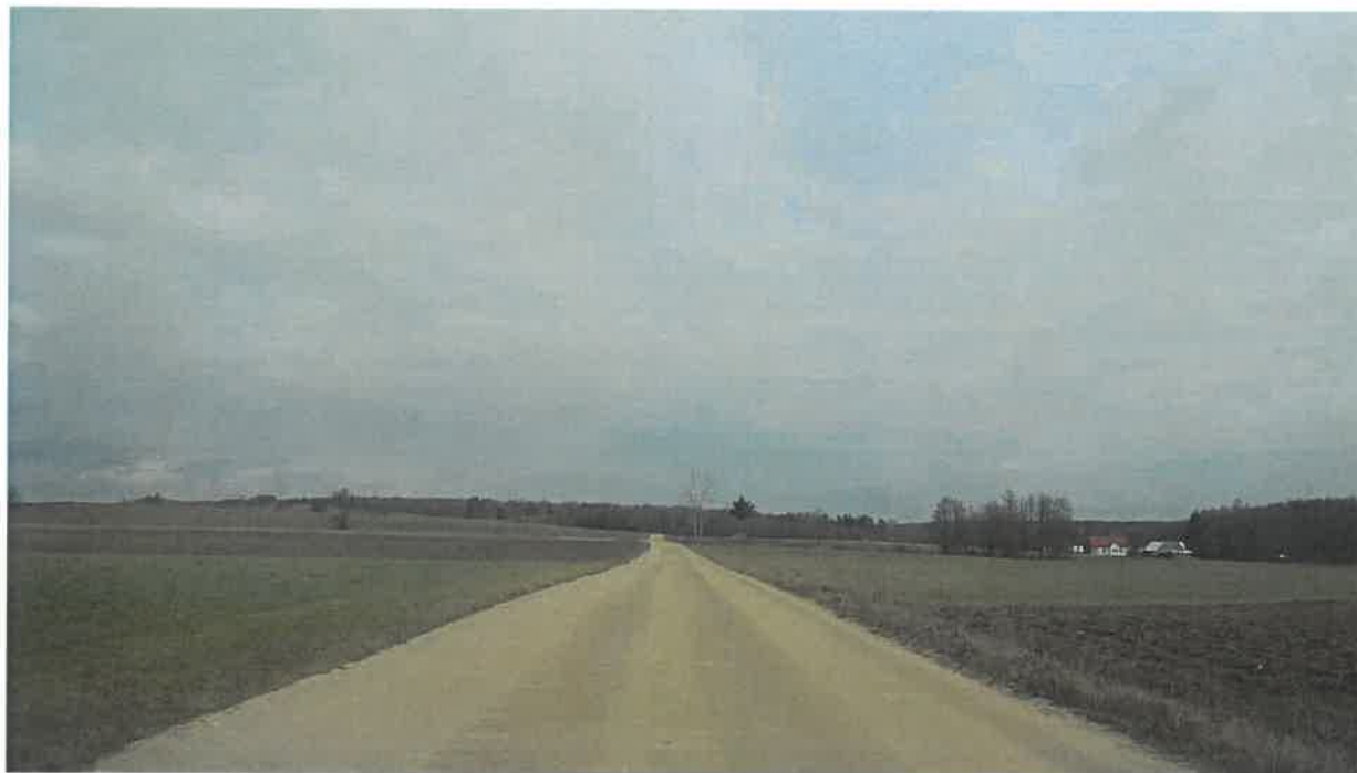
Droga nr 1266B przed przebudową
