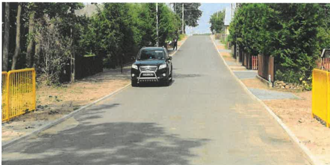
Droga 1262B po przebudowie
