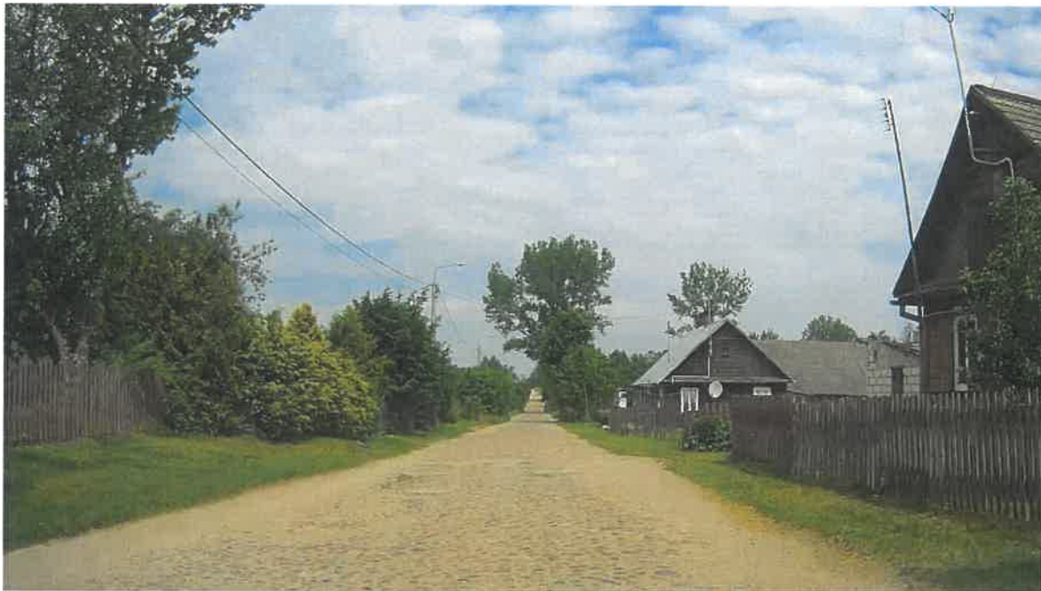
Droga nr 1262B przed przebudową
