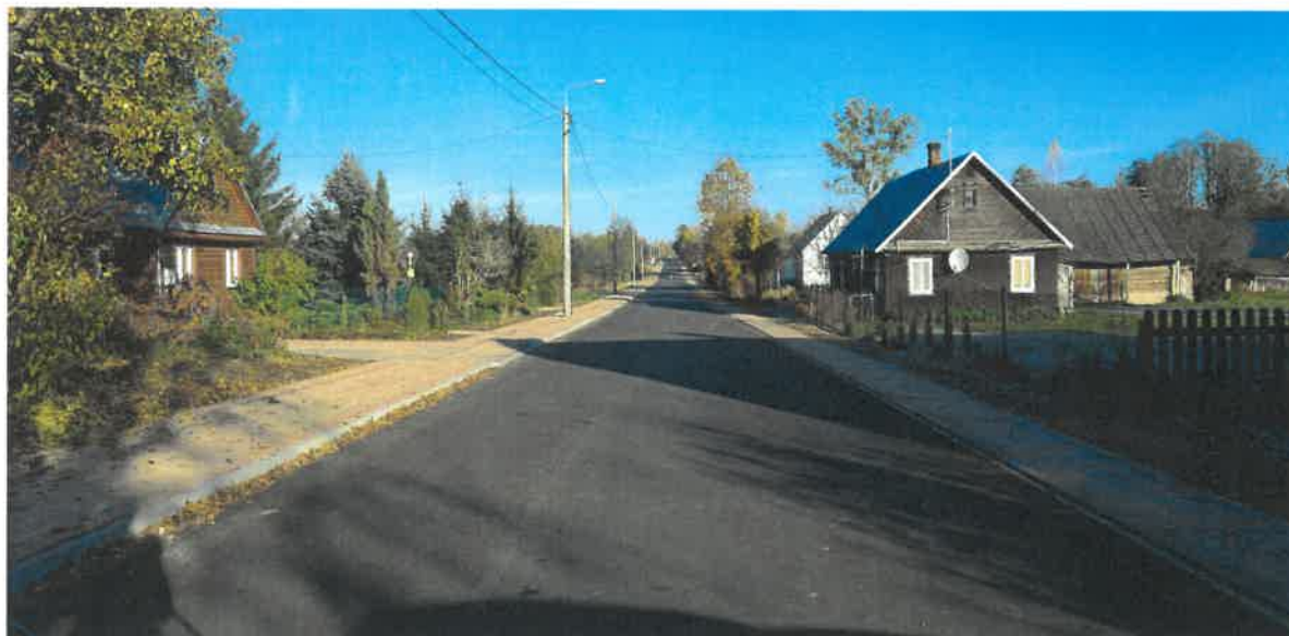
Droga nr 1262B po przebudowie
