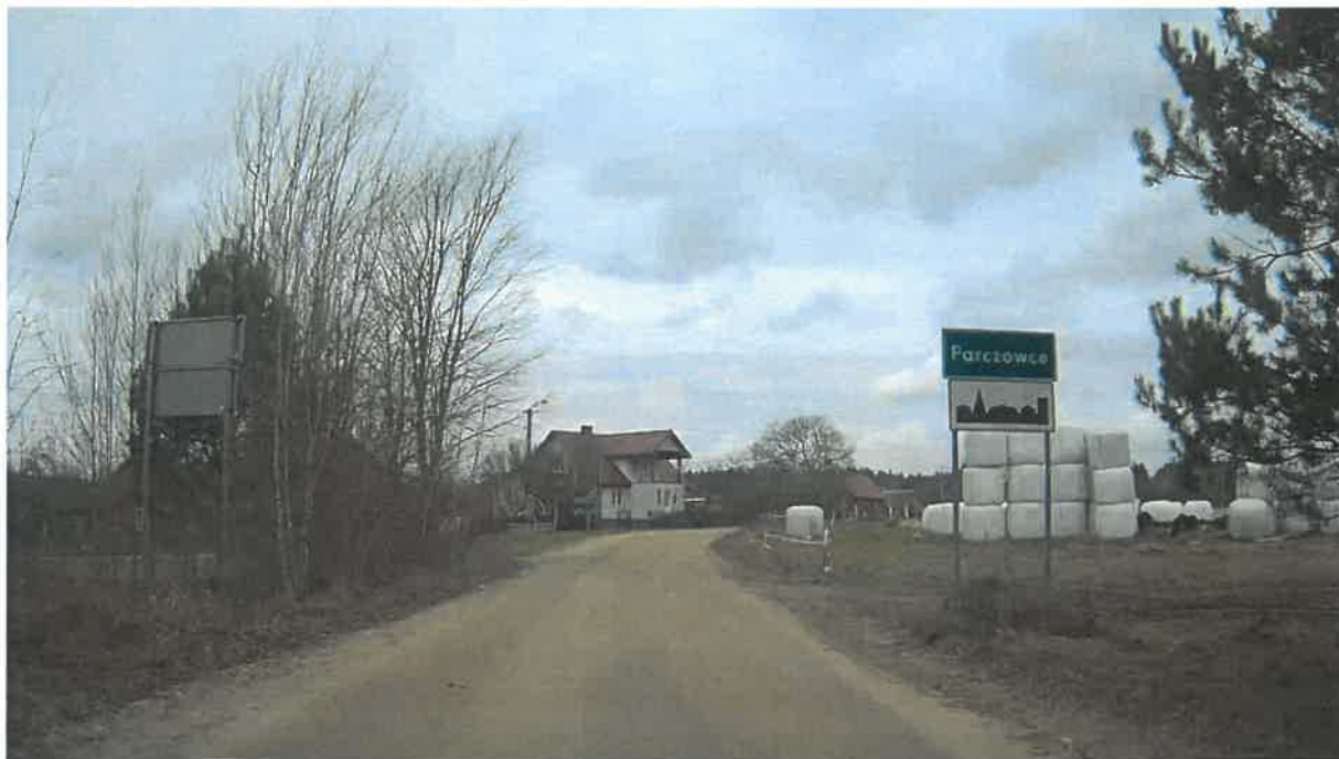
Droga nr 1266B przed przebudową
