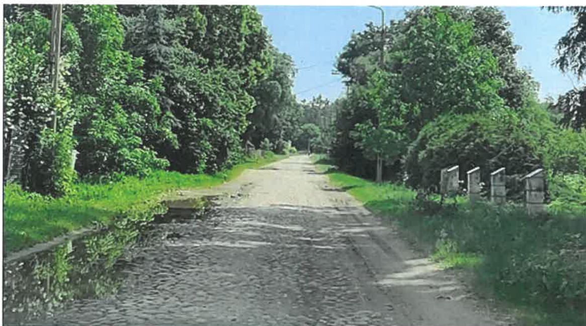
Droga Nr 1246B przed przebudową
