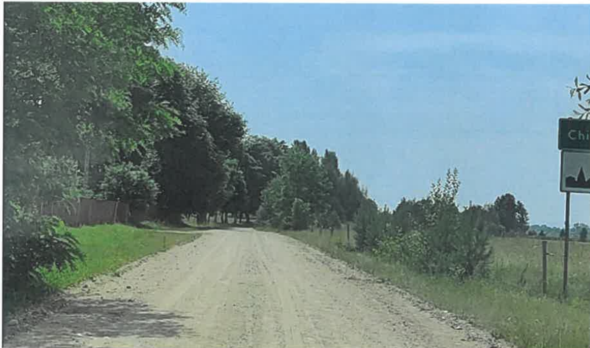
Droga Nr 1246B przed przebudową
