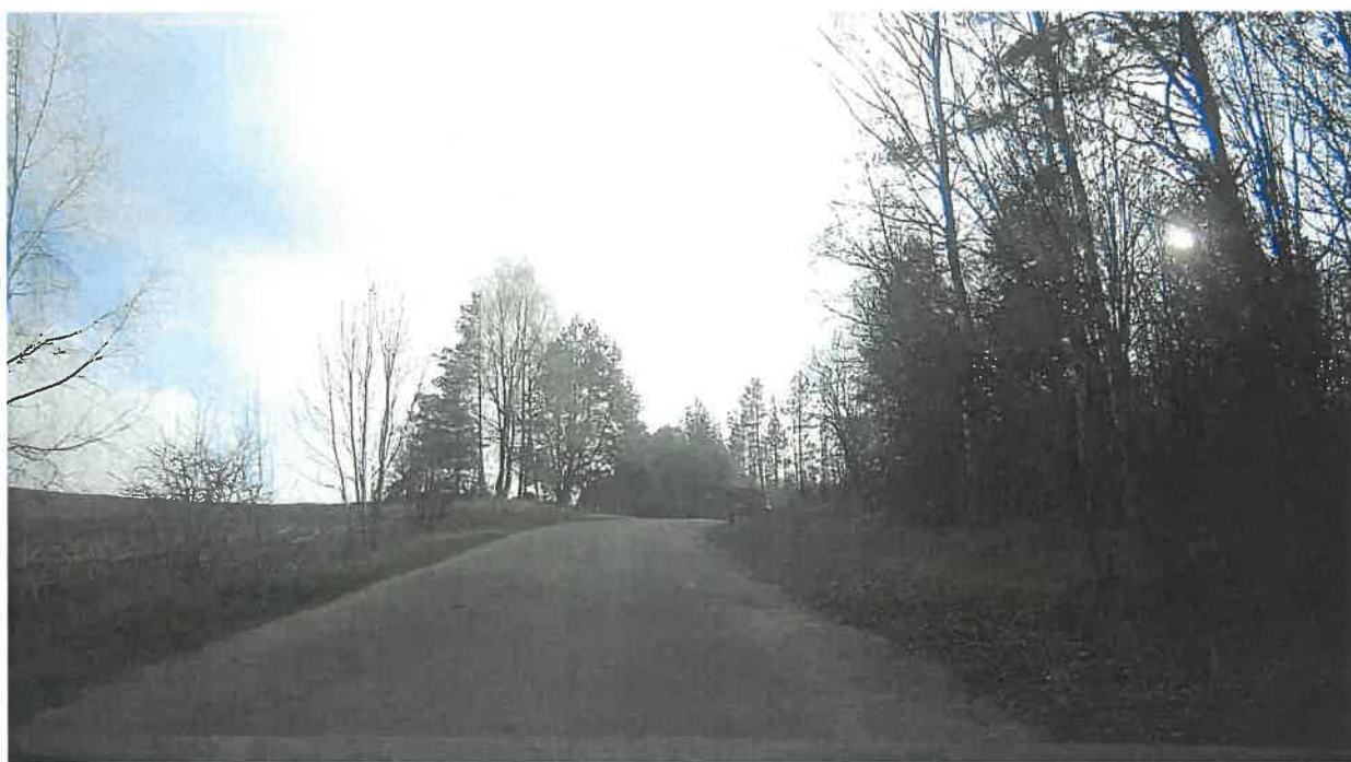
Droga nr 1259B przed przebudową
