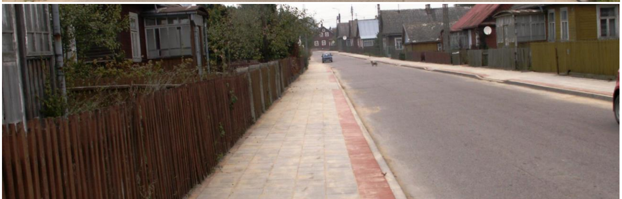
Droga 1326B – ul. Trofimowska w Janowie przed i po remoncie chodnika
