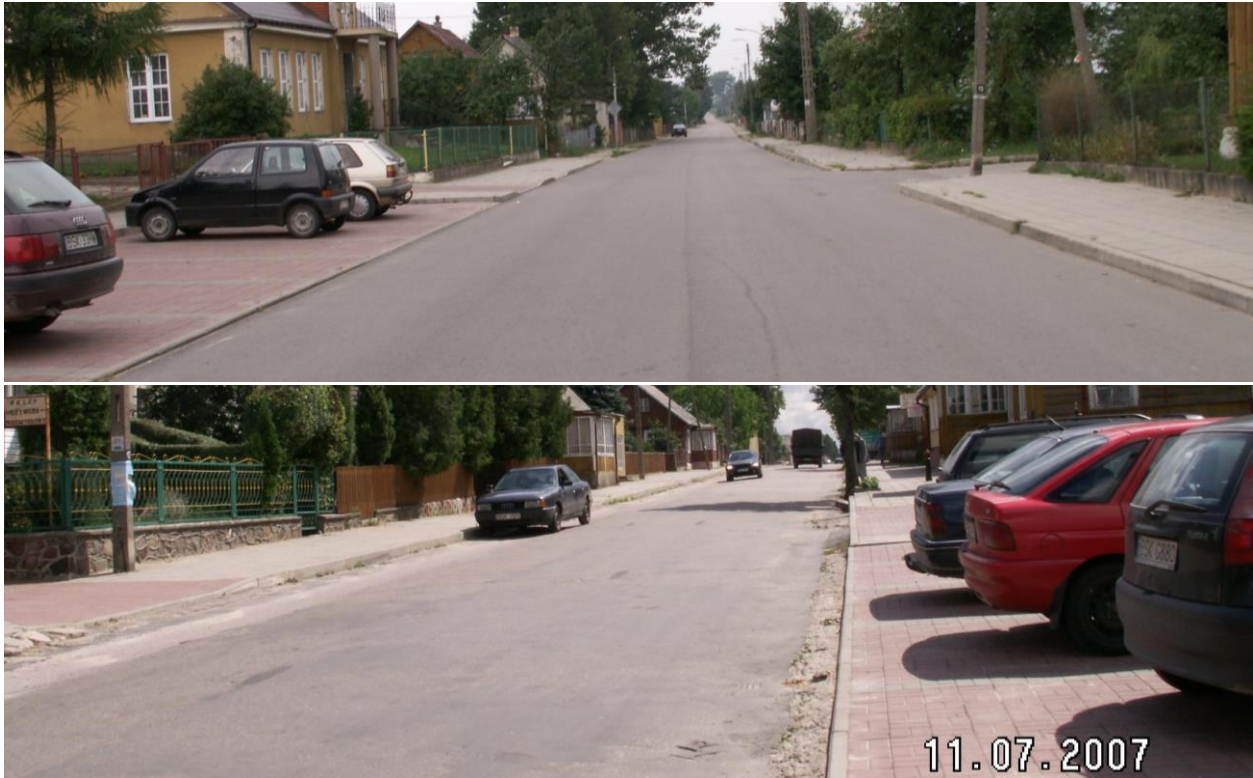
ul. Goniądzka przed i po przebudowie
