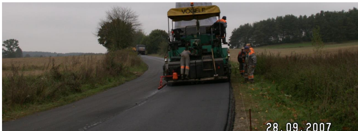
Droga 1303B przed i w trakcie remontu (odcinek Bogusze – Szyndziel)
