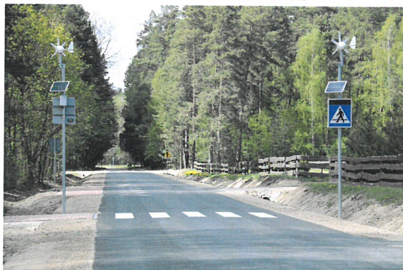
Droga 1307B po przebudowie
