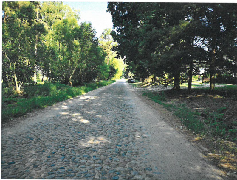
Droga 1307B przed przebudową
