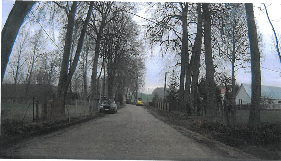
Droga 1270B przed przebudową
