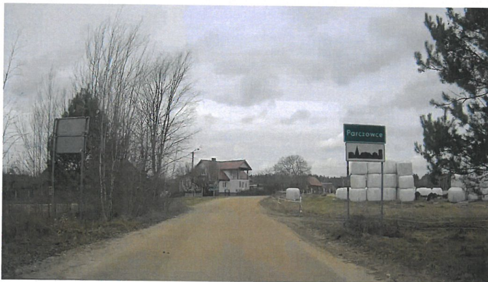
Droga nr 1266B przed przebudową
