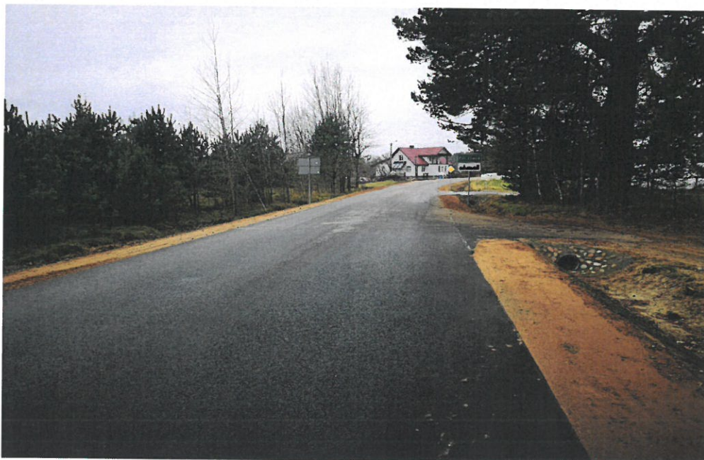
Droga nr 1266B po przebudowie
