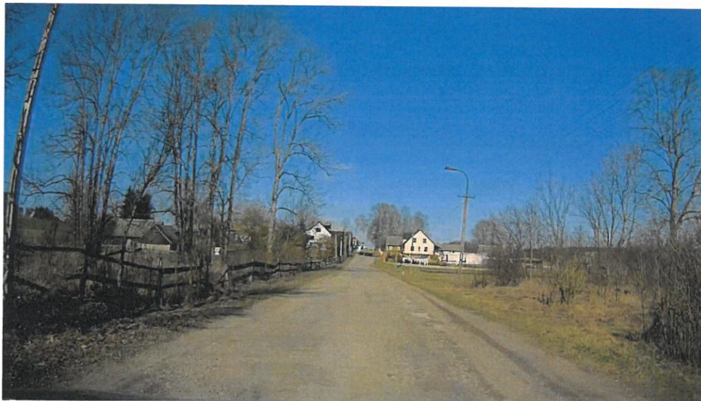
Droga 1261B przed przebudową
