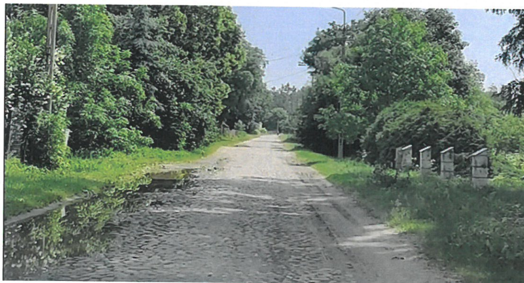
Droga Nr 1246B przed przebudową
