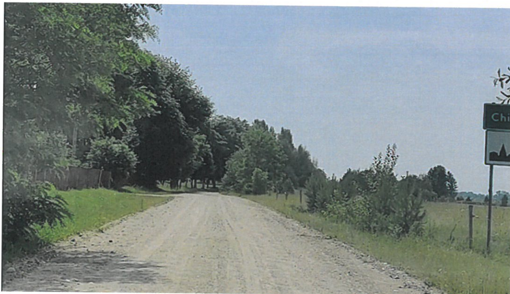
Droga Nr 1246B przed przebudową
