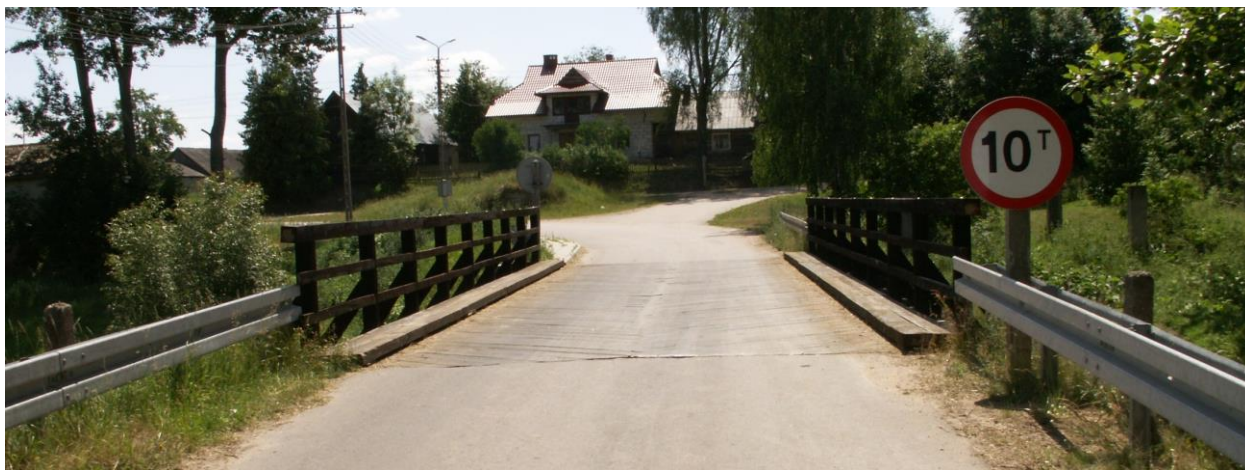
Most w Kamiennej Starej po remoncie
